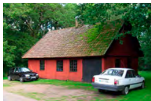
Lindhults gårdssmedja förvaltas och sköts sedan 1982 av hembygdsföreningen. Byggnaden brann ned maj 2011.
