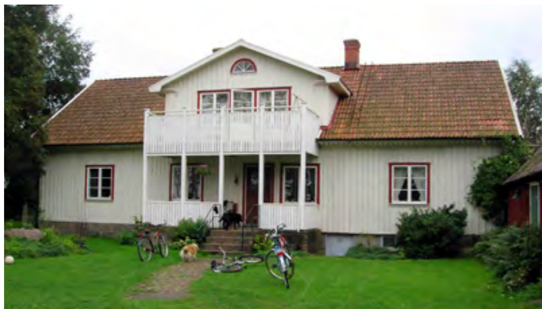
Hönryd 4:1 med välbevarad manbyggnad av salstyp med frontespis och ljusst målad fasad.
