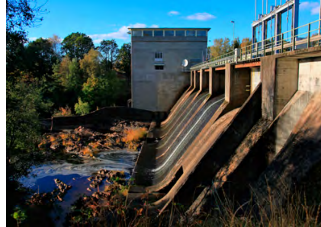
Skogsforsens kraftverk byggdes helt i armerad betong, inklusive maskinhusets tak, vilket skulle skydda mot flygbomber – ett verkligt hot åren kring 1940.
