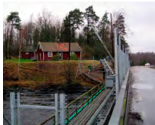
Askome 5:8. Torpstuga vid Ätraforsdammen.
