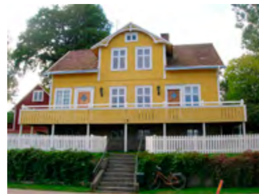
Kärreberg 3:32 vid Stationsgatan uppfördes 1916 av byggmästare Adolf Pettersson, som byggt en stor del av husen i stationsområdet.
