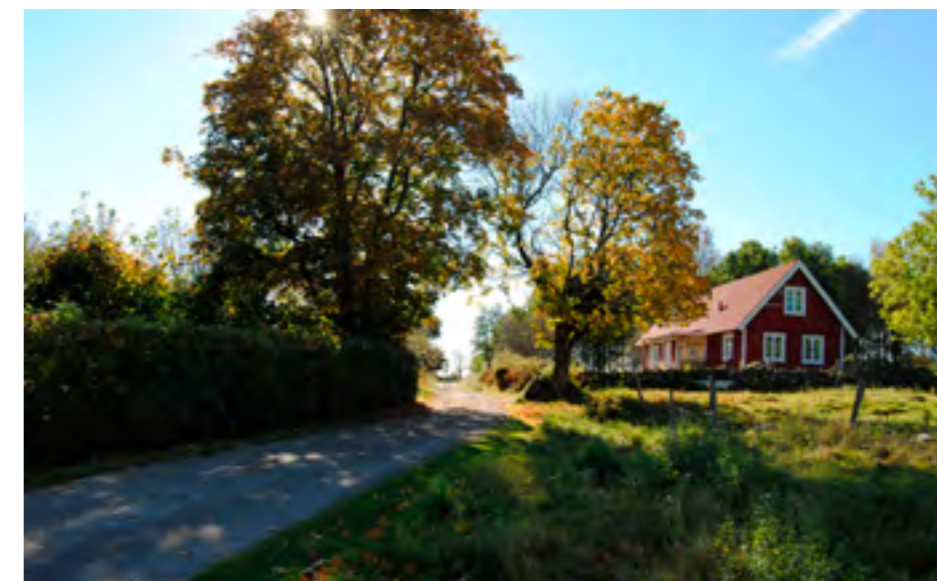
Bostadshuset på Berg 1:11 är ett modernt hus byggt i traditionell stil. Det är ett bra exempel på anpassning till det befintliga bebyggelsemönstret.
