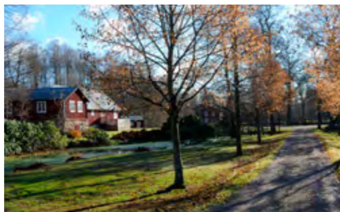
Vy söderut från uppfarten. Tv ett magasin med källarvåning bakom ett bostadshus. Längre bort skymtar ett bryggshus och t h kvarnbyggnaden.
