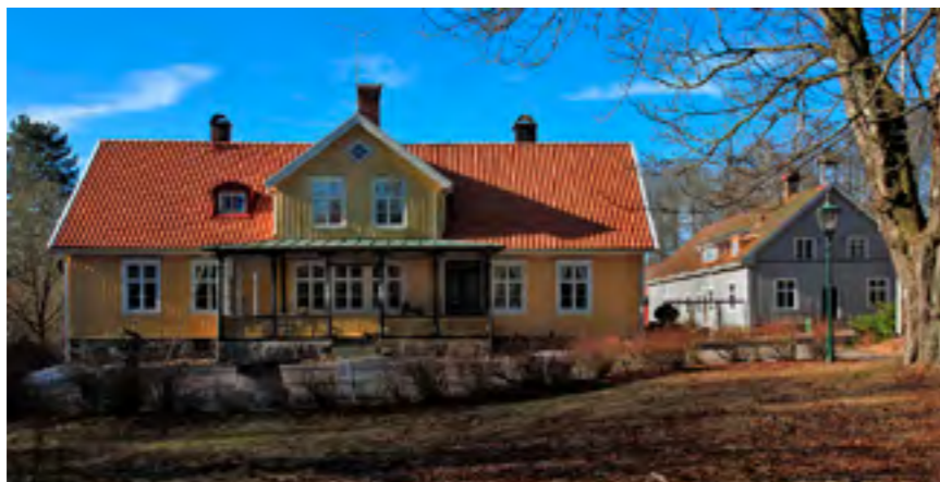
Manbyggnaden från 1843 med den fina verandan åt norr. Byggnaden th är f d brygghuset.
