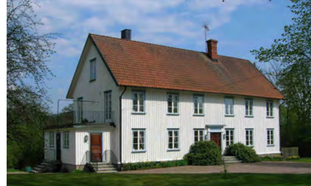
Prästgården. Sedan 2008 innehåller byggnaden restaurang och pensionat Vinbergs prästgård.
