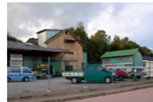
Industribyggnad i anslutning till f d järnvägen. Kärreberg 3:81.
