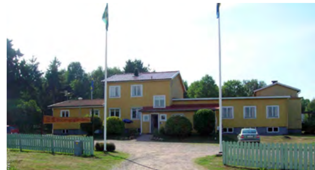
SMU-gården i Boberg. Uppförd som barnkoloni 1946.
