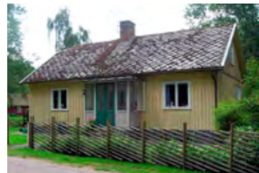
Lindhults gods arbetarbostäder. Tidigare smedbostad, uppförd ca 1900.
