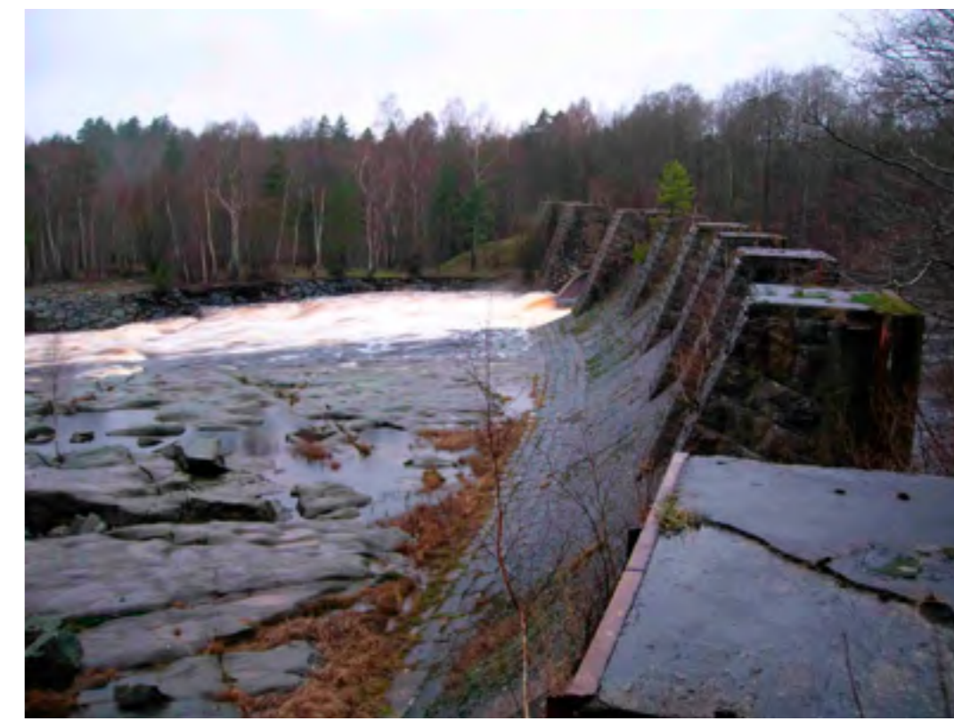
Det s k Döda fallet och den övergivna dammkonstruktionen vid Yngeredsfors från 1905-07-års utbyggnad.
