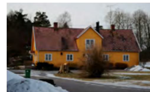
Manbyggnaden från 1855 fick sin nuvarande utformning med frontespis m m efter en omfattande renovering på 1940-talet. Tidigare var den utformad som en traditionell hallandslänga.
