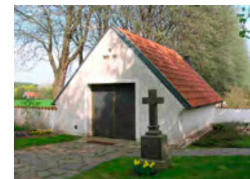
Bårhus uppfört på 1950-talet.
