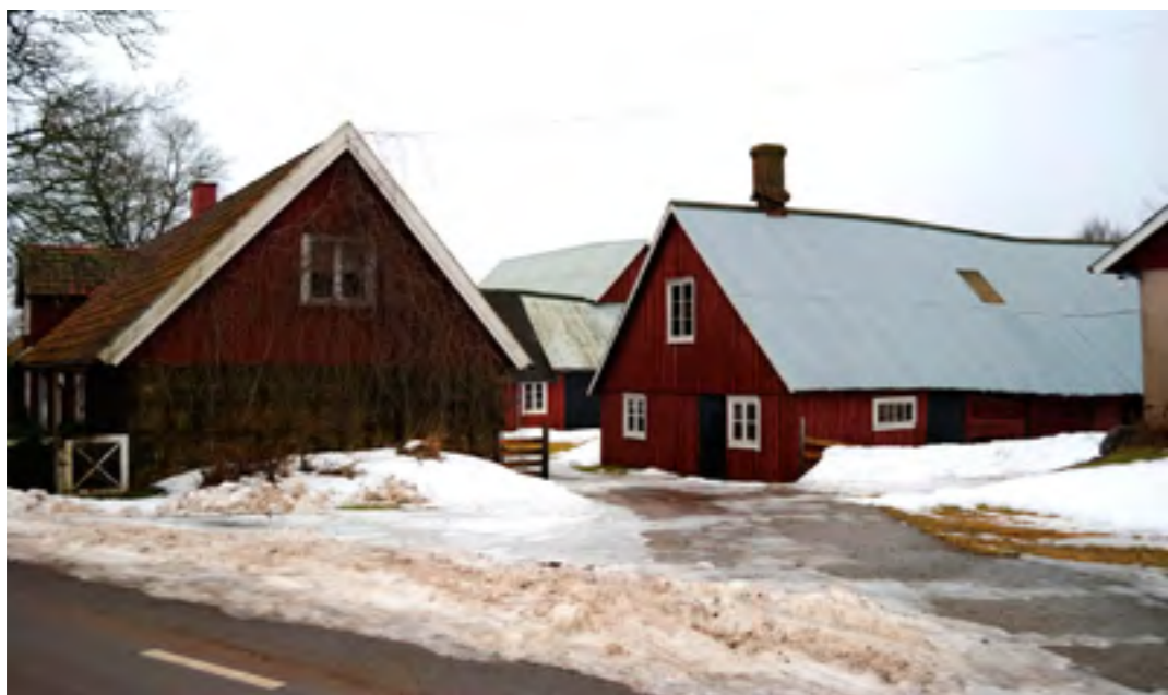
Gården Eftra 5:2 ligger kvar i sitt gamla läge vid vägkorsningen. Gårdsformen var fram till 1950-talet helt sluten. Norr om gården finns välhävdad betesmark. Ekonomibyggnaden i skiftesverket h har tyvärr nyligen rivits.
