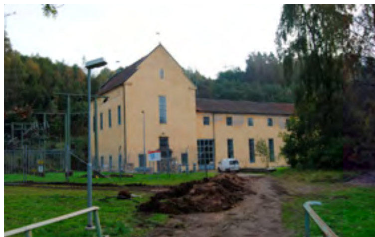
Det nya kraftverket nedströms utnyttjar en fallhöjd på 24 meter. Maskinhuset fick en mycket påkostad utformning både ut- och invändigt.
