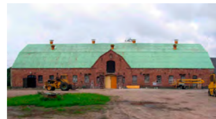
Lis gård, ladugård i tegel uppförd 1922.
