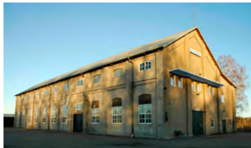
Smältverksbyggnad uppförd 1917-18 för AB Héroults Elektriska Stål. Stålvirket gick i konkurs redan 1920. Byggnaden är en tydlig symbol för den avbrutna samhällsutvecklingen i Ätrafors.
