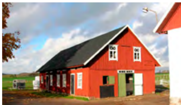
Stallbyggnad från början av 1900-talet med fina detaljer.
