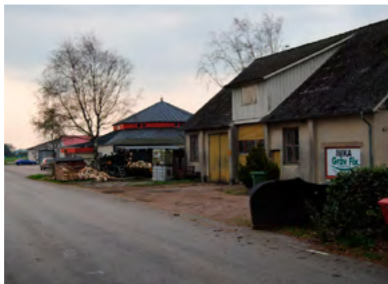
Verkstad och dansbanan "Centrum" uppförd 1939 vid järnvägsområdet i södra delen av samhället.
