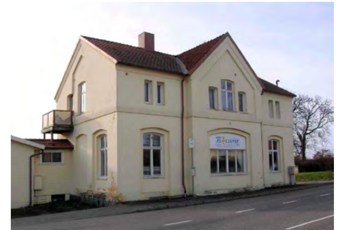
Hebergs järnvägsstation. Liknande stationshus byggdes utefter västkustbanan. Ursprungligen hade de tegelfasad.
