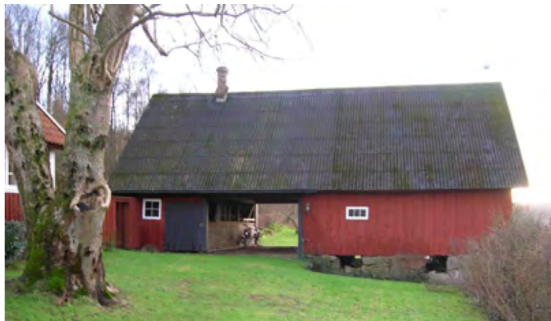
Ekonomibyggnad med brygghus och genomgående port.
