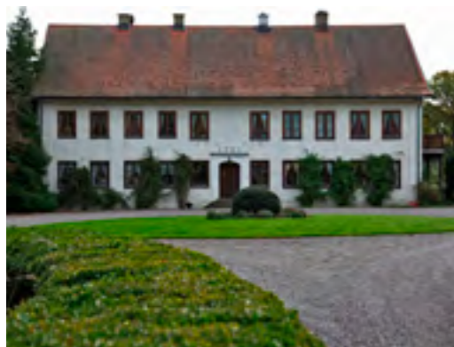
Corps-de-logiet påbyggdes med en våning 1781. Initialerna "FML" och "CvM" över årtalet vid entrén står för dåvarande ägarparet Fredrik Malcolm Lilliehöök och Charlotte von Mentzer.
