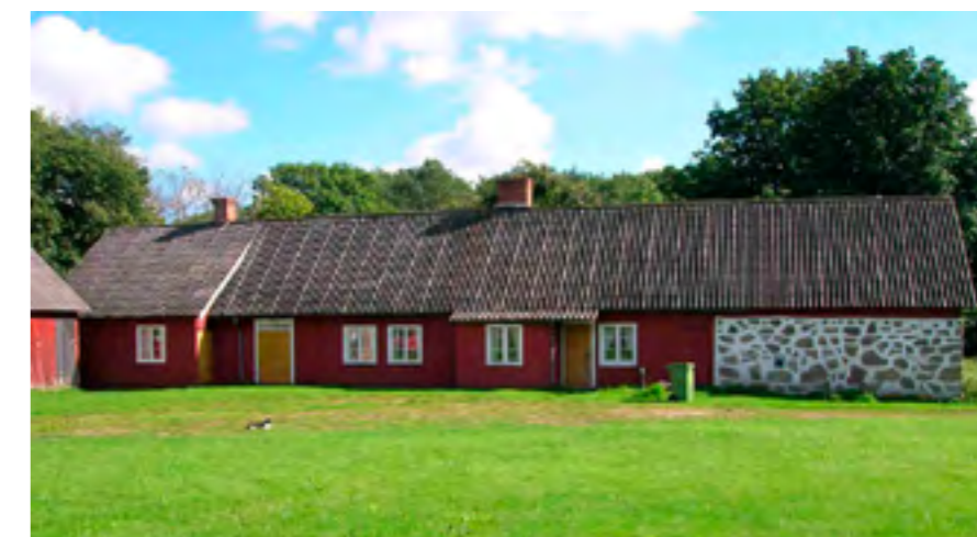
Manbyggnaden är en lång länga med inbyggd murad källare.
