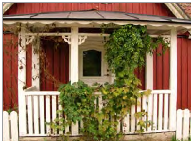
Verandan på huset vid Albertinavägen.
