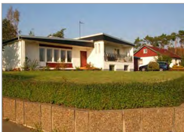
Till vänster och överst till höger: Hedvägen. Mitten till höger: Ringare-Gustafs väg med gaveln mot Hedvägen. Till höger: Vinbovägen.
